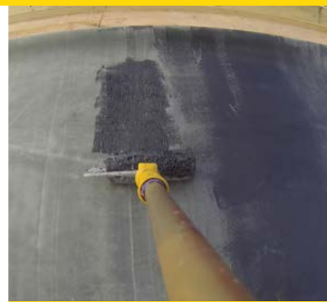
AANBRENGEN VAN DE LIJM
